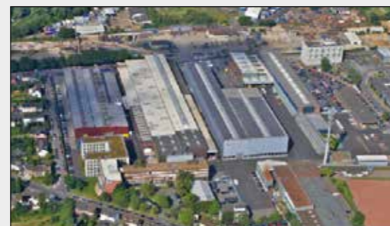
SMS group GmbH, Mönchengladbach (Germany)
