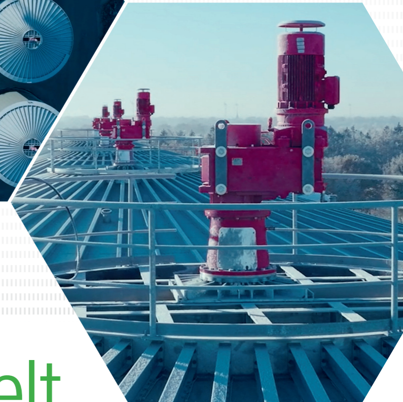
Antriebe für Europas größten Biogas-Fermenter In einer Biomethananlage der Superlative im niedersächsischen Friesoythe arbeiten die Rührwerke mit robusten Industriegetrieben aus der MAXXDRIVE®-Baureihe von NORD
