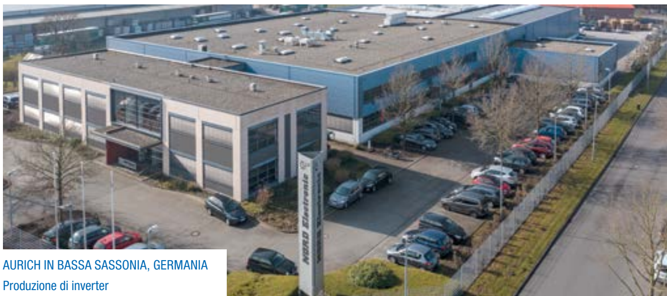
SEDE CENTRALE DI GETRIEBEBAU NORD A BARGTEHEIDE, PRESSO AMBURGO, GERMANIA Ricerca e sviluppo, centro logistico
