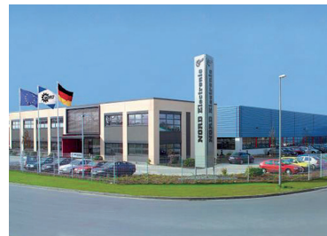
Fabricação de inversores
